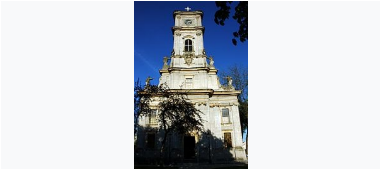
Római katolikus (volt piarista) templom
